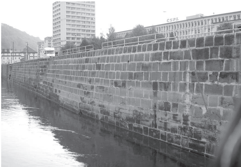
Obr. 6. Nově rekonstruovaná část nábrežní zdi v Děčíně poblíž bývalé restaurace Atlantik s ponechanou částí původní drenáže používanou hnízdicími břehulemi říčnicími. Foto P. Benda, 16. 8. 2005.
