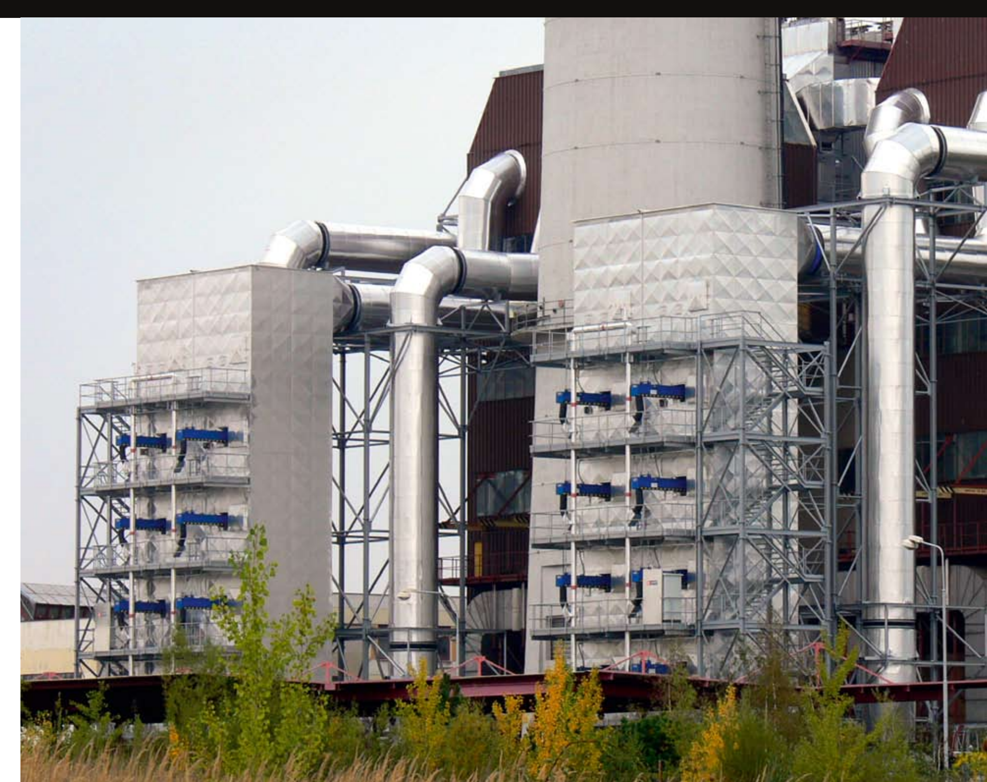
Detailní záběr na dioxinové filtry pražské malešické spalovny
